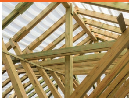
Bois de structure raboté – pin sylvestre de France – classe 4 vert.
