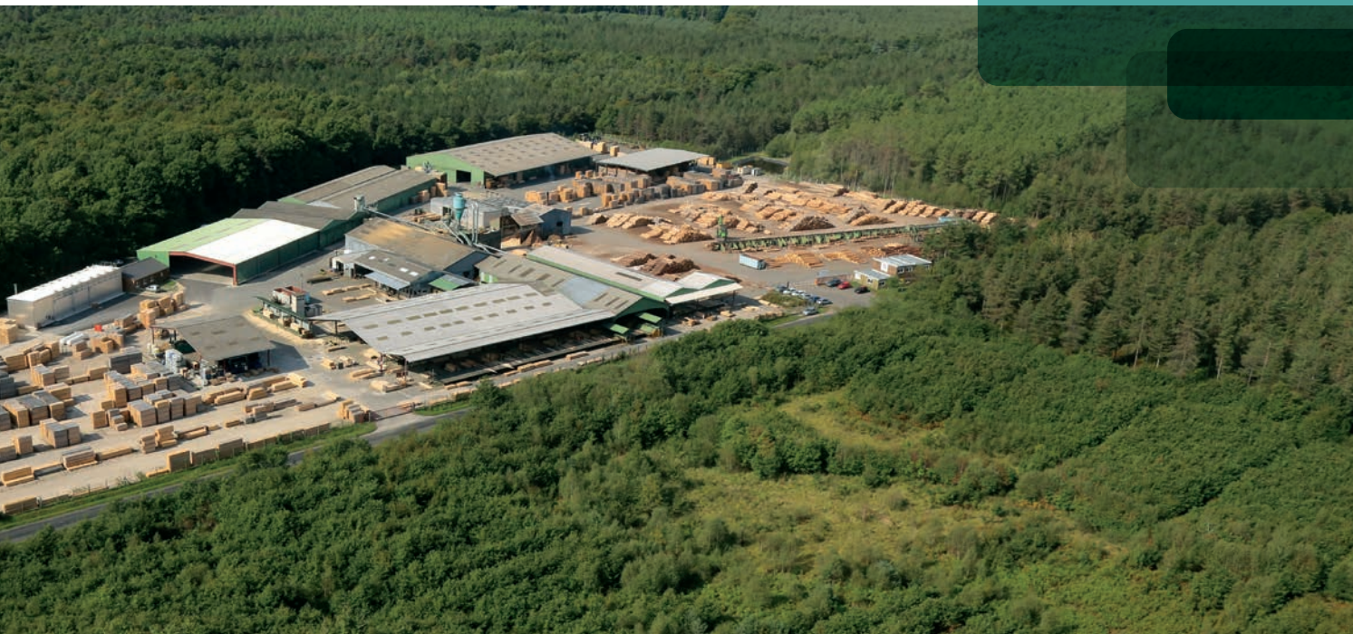
Le site industriel de Vitry-aux-Loges.
