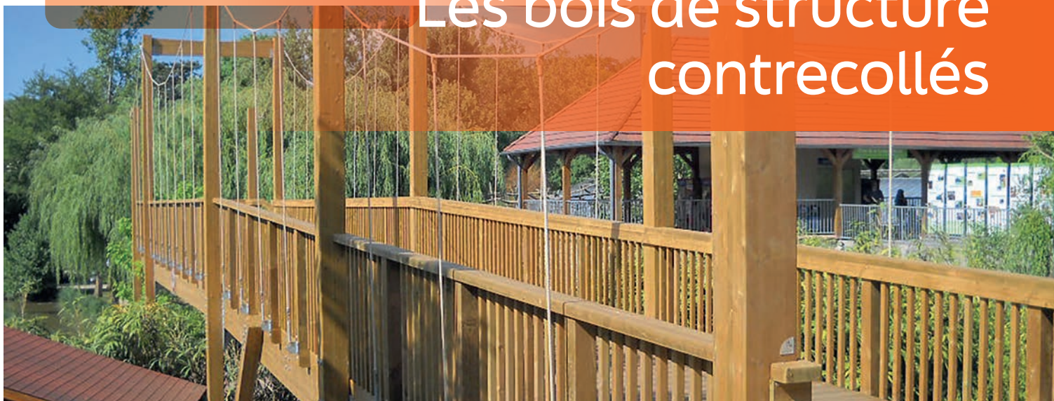
Pont avec poteaux contrecollés – pin du Nord rouge – autoclave vert.
