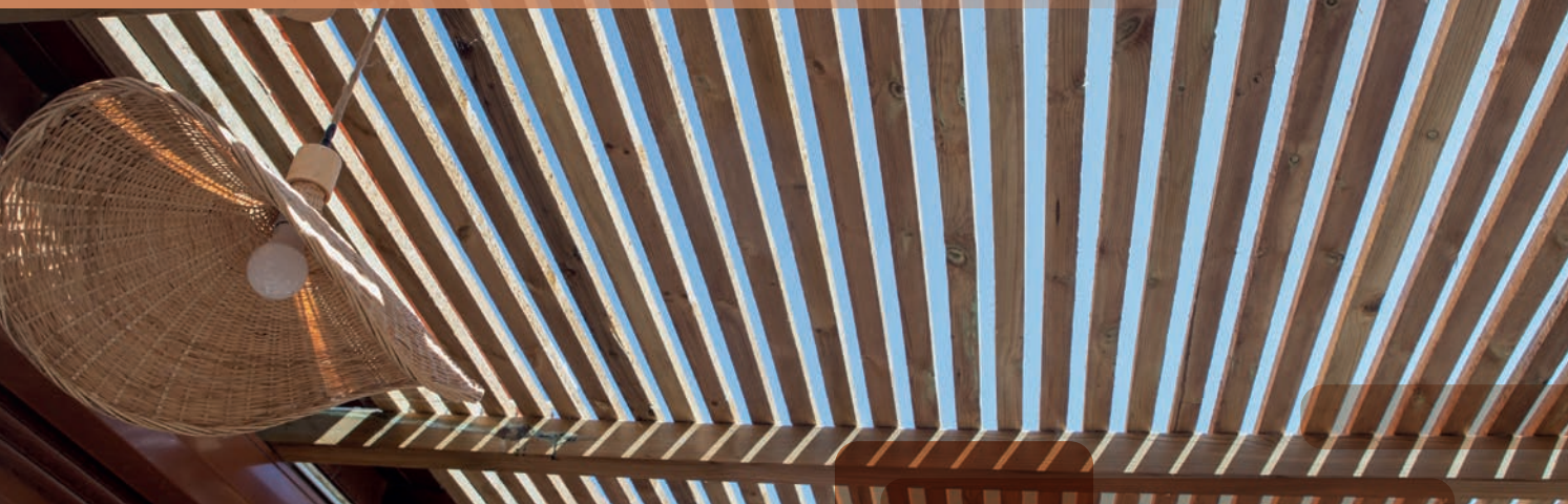
Exemple de mise en œuvre.
