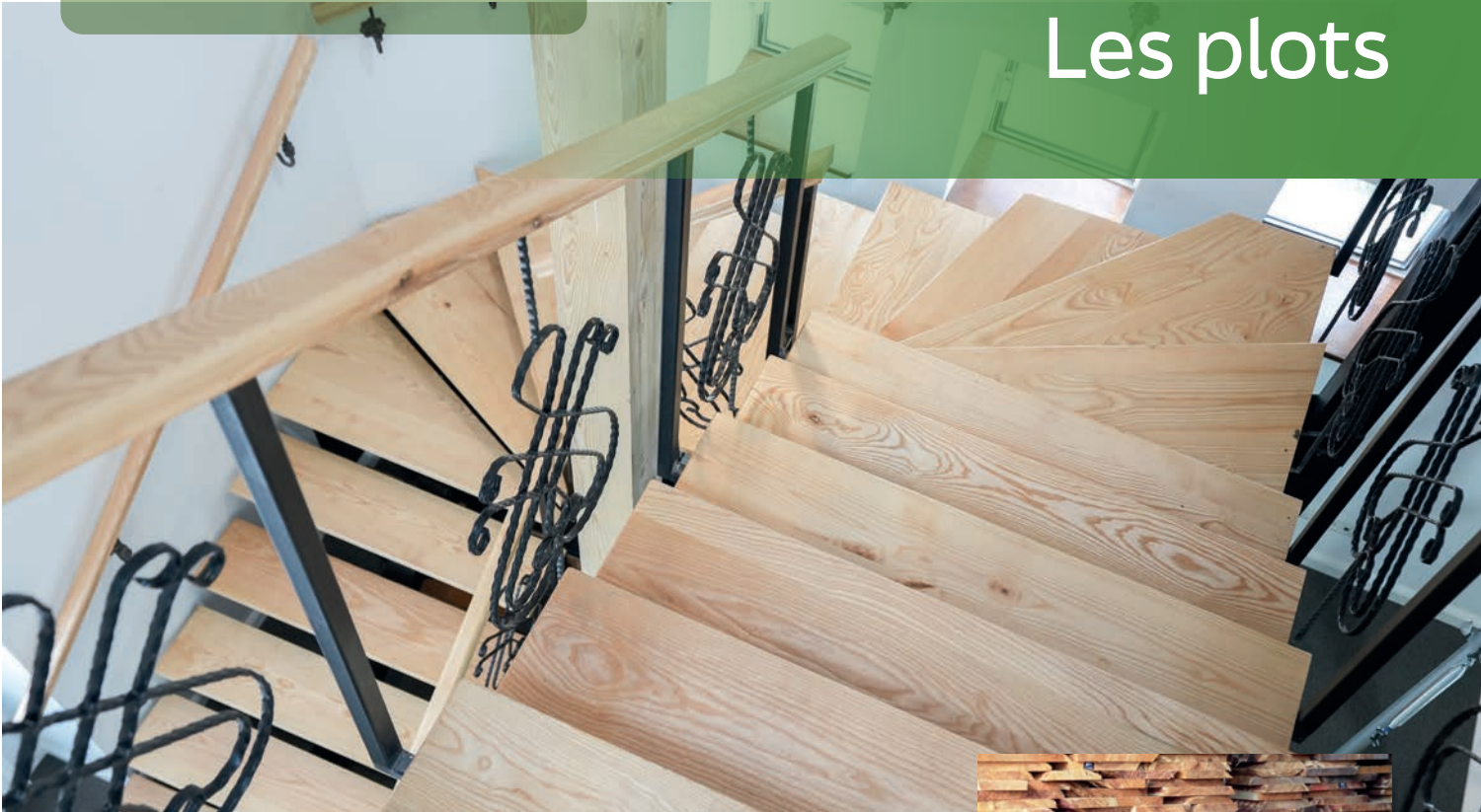
Exemple de mise en œuvre.
