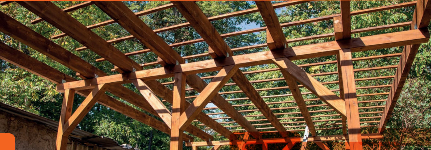
Exemple de mise en œuvre.
