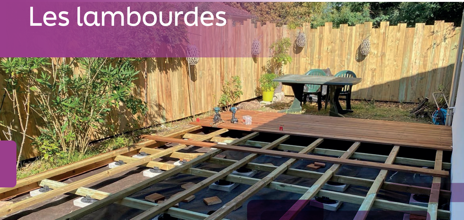
Exemple de mise en œuvre.
