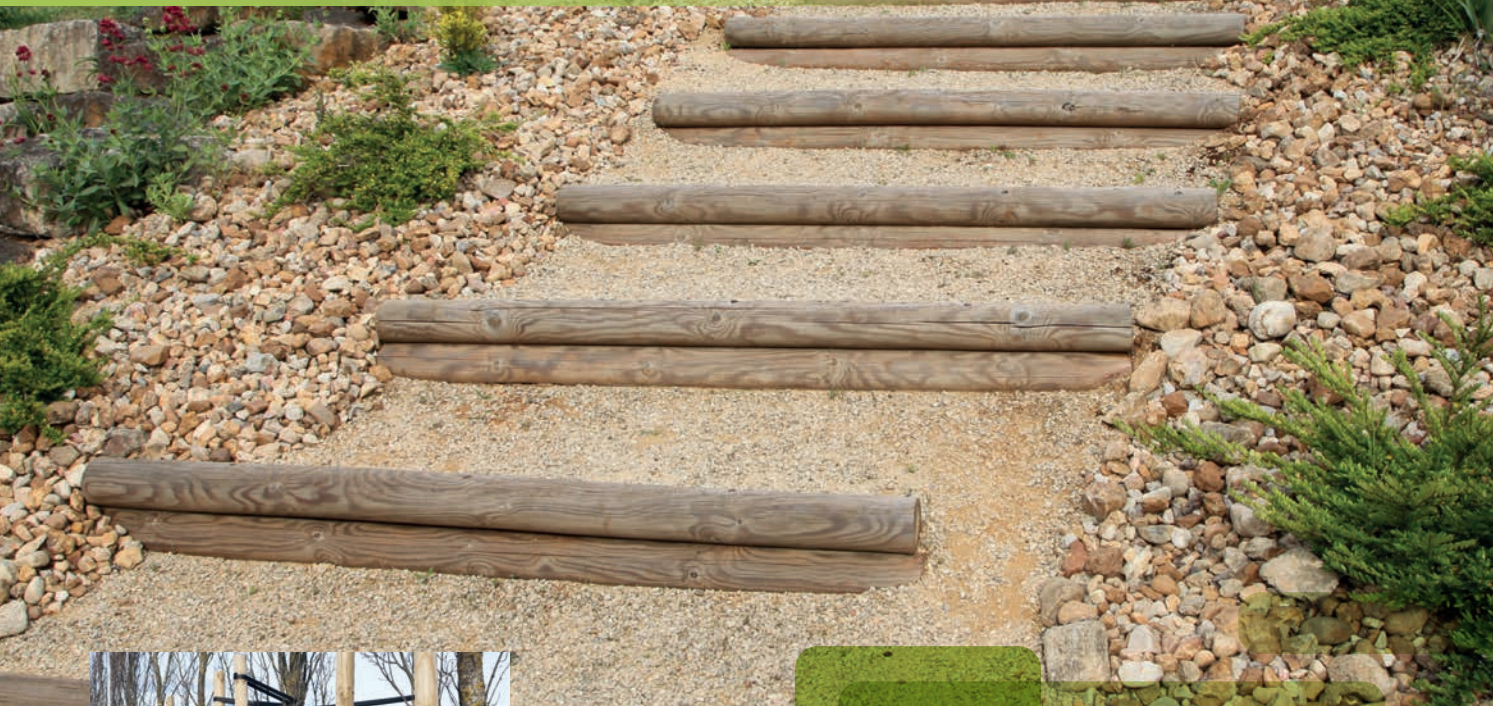
Exemple de mise en œuvre.
